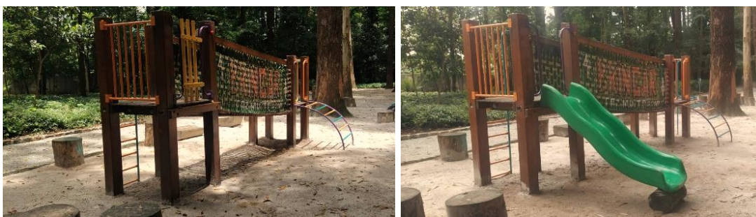
Figura 20: Instalação do escorregador no Playground.
