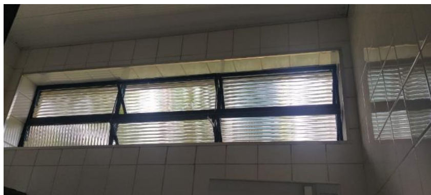
Figura 21: Troca dos vidros quebrados.
